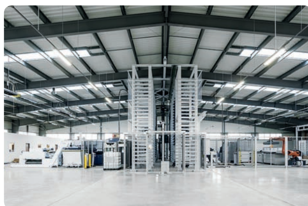
Vollautomatisiertes System - Entwicklungshalle
