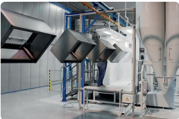
Spritzautomat der Pulverlackiererei
